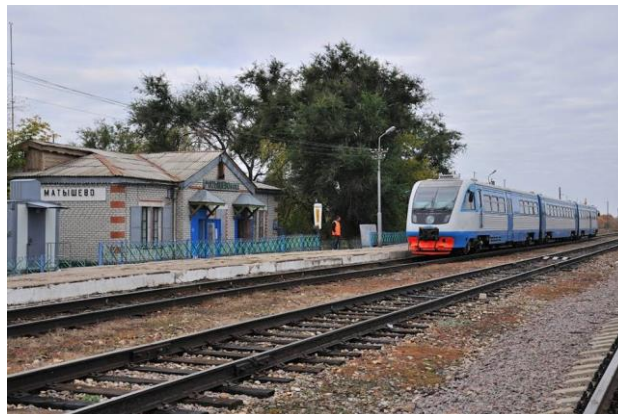
Станция Матышево (современный вид) имела в годы войны стратегическое значение для обороны Сталинграда (здесь и далее фото – из работы автора)
